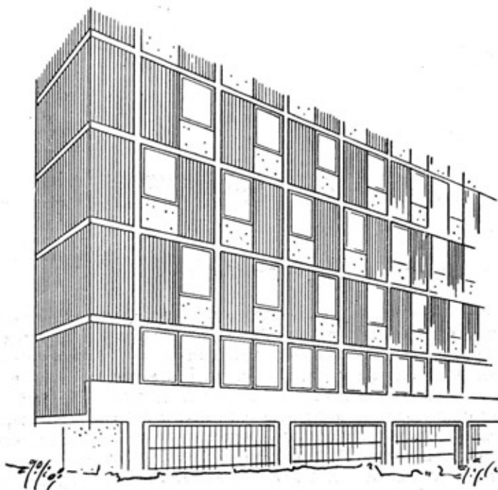
Рис. 17. Конторское здание в Риме с удачно решенной формой ранд-балки, сливающейся с подоконной стенкой
