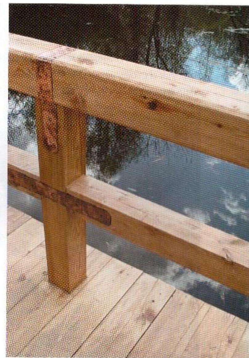
Перила мостиков нуждаются в надежном креплении
