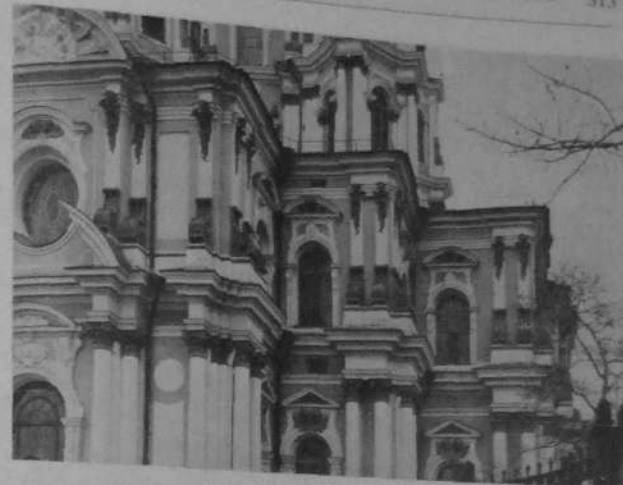
6.27 Детали западного фасада собора Смольного монастыря (1748—1764 гг.) в Петербурге. Арх. Ф. Б. Растрелли
