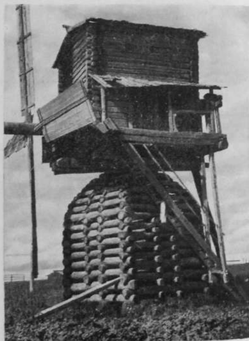
1.23 Основные типы мельниц-столбовок а — на столбах; б — на клетях; в — на раме
