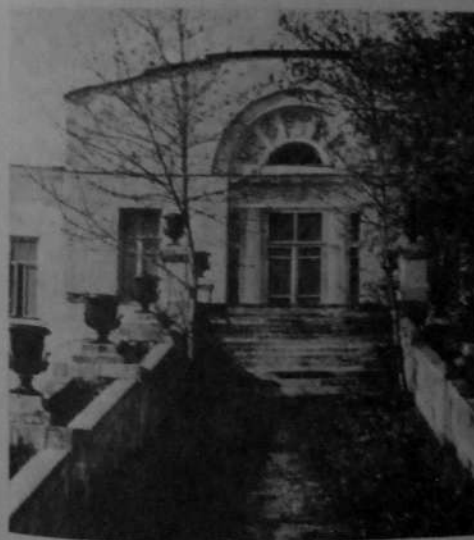
7.92 Главный дом в усадьбе Усачевых — Найдено- вых (1829—1831 гг.) в Москве. Архитекторы Д. И. Жиларди, А. Г. Григорьев
