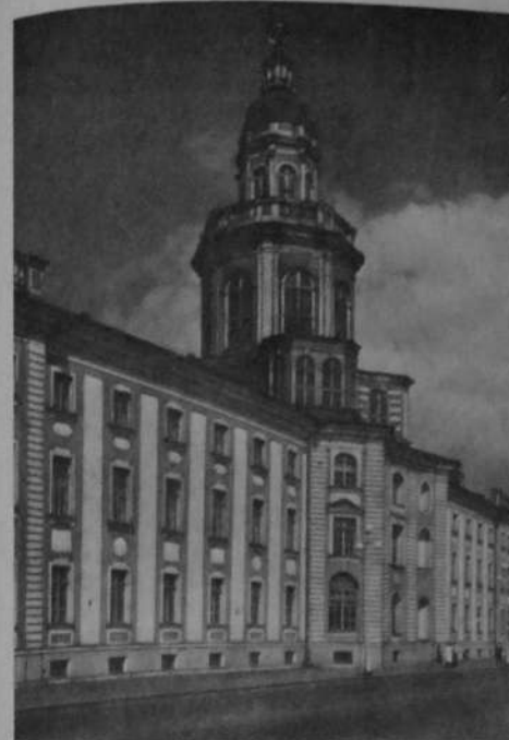
6.13 Здание Кунсткамеры в Петербурге (1718—1734 гг.).
