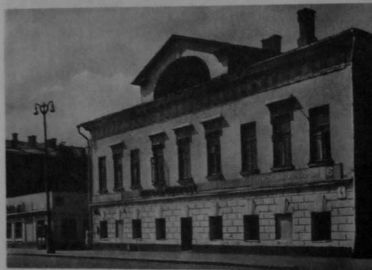
7.90 Вдовый дом (1775 г.) в Москве. Арх. И. Д. Жиларди. В 1818—1823 гг. перестроил арх. Д. И. Жиларди
