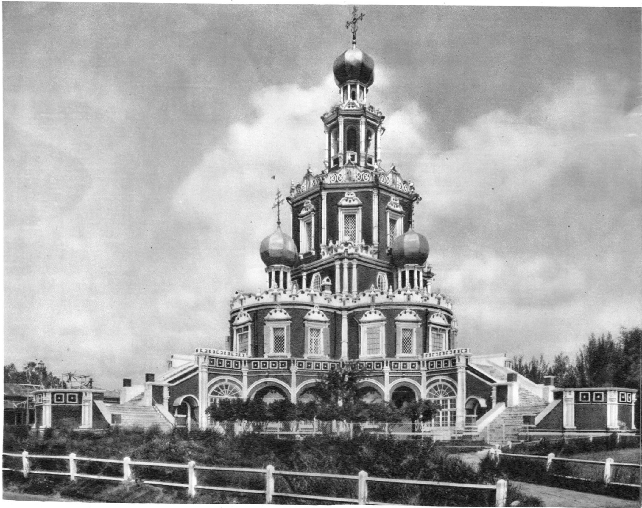
ВИД С ЮГО-ЗАПАДА
