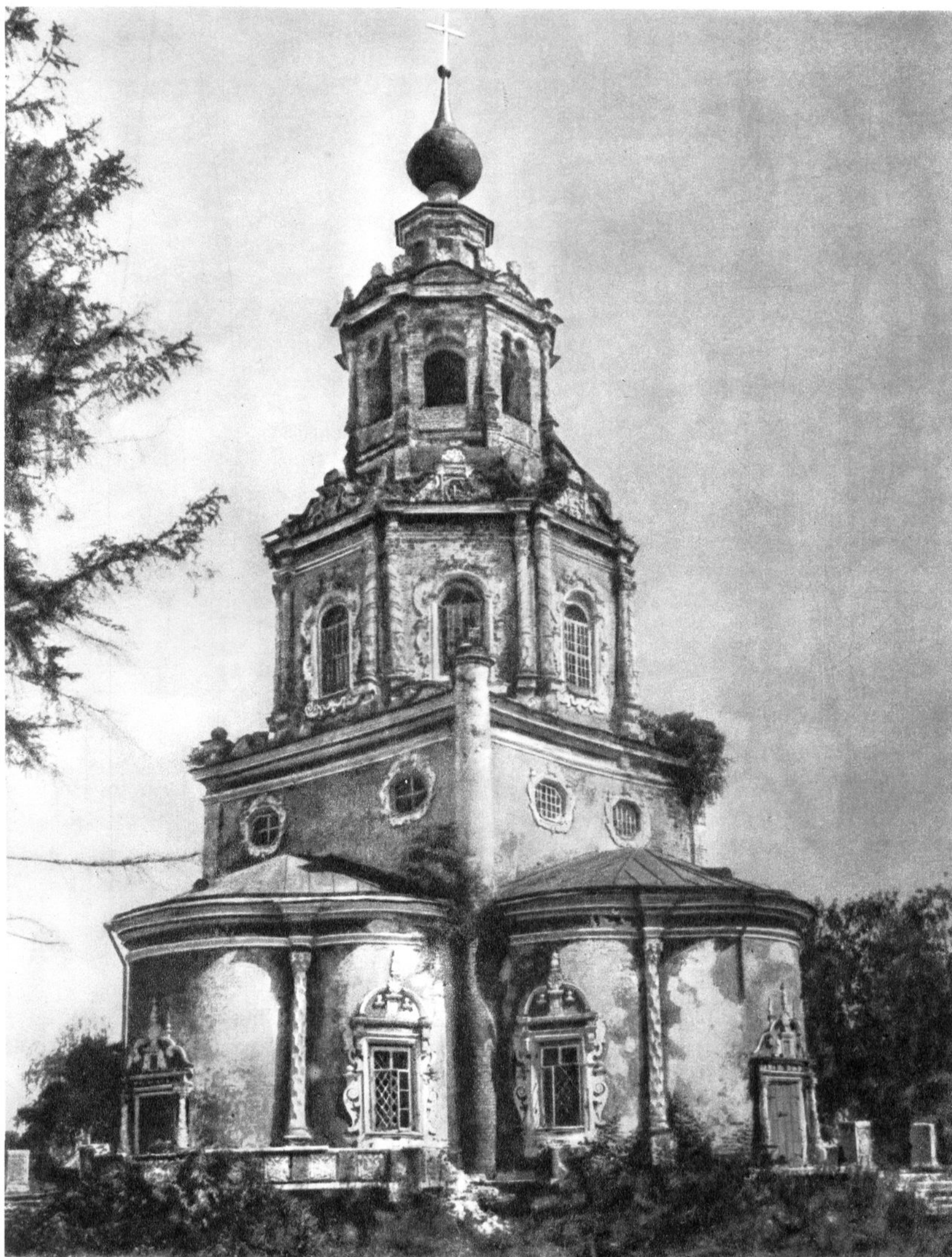
ОБЩИЙ ВИД С СЕВЕРО-ЗАПАДА
