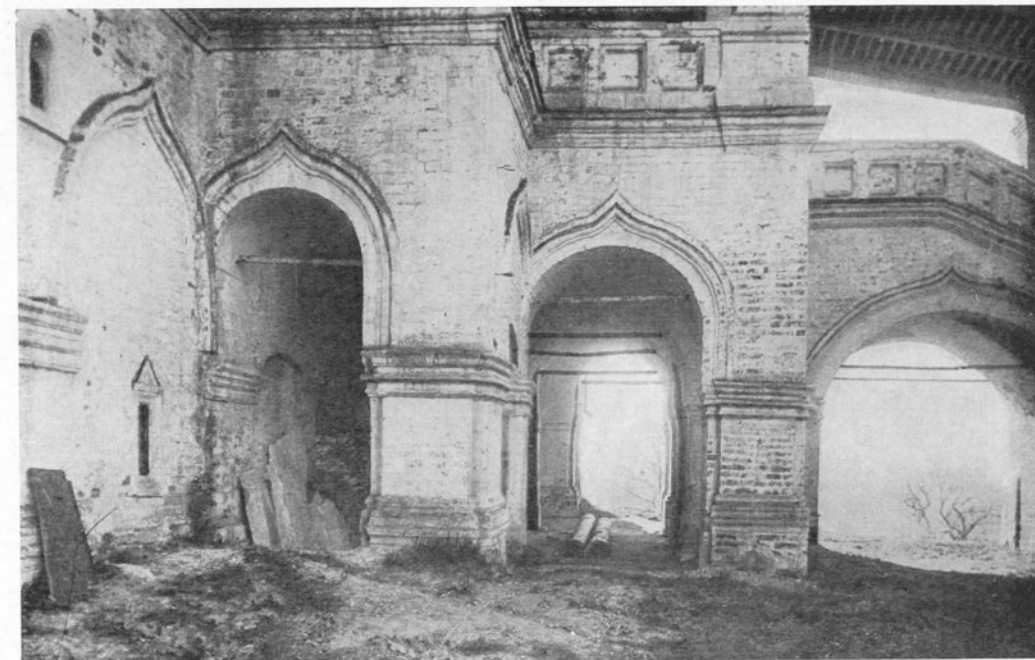
Примыкание южного крыльца к подклету
