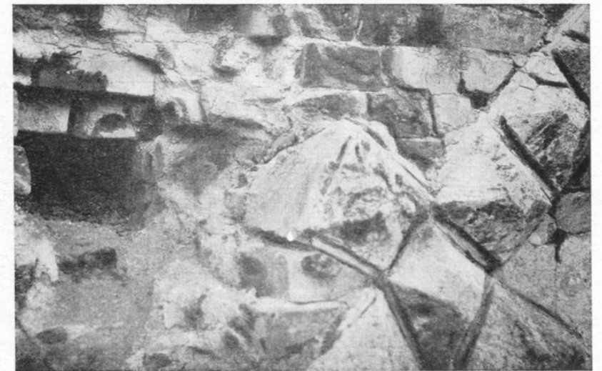
Деталь заделки граненых четок шатра
