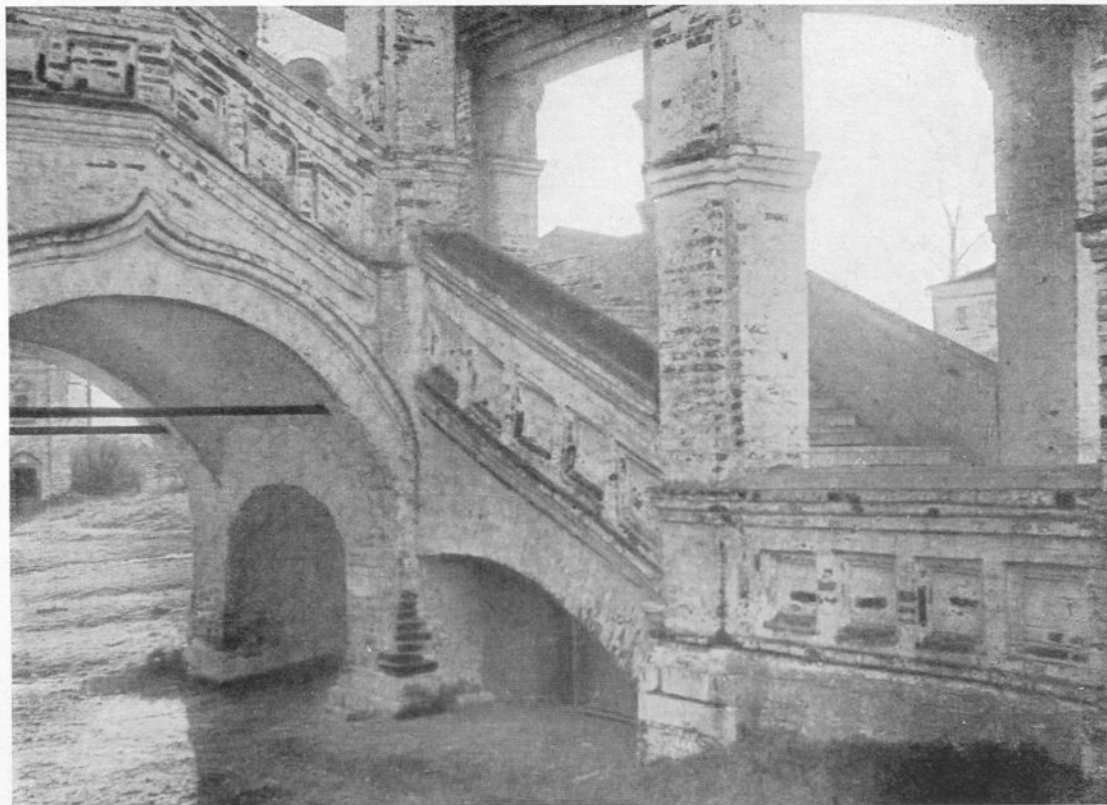
Примыкание западного крыльца к подклету
