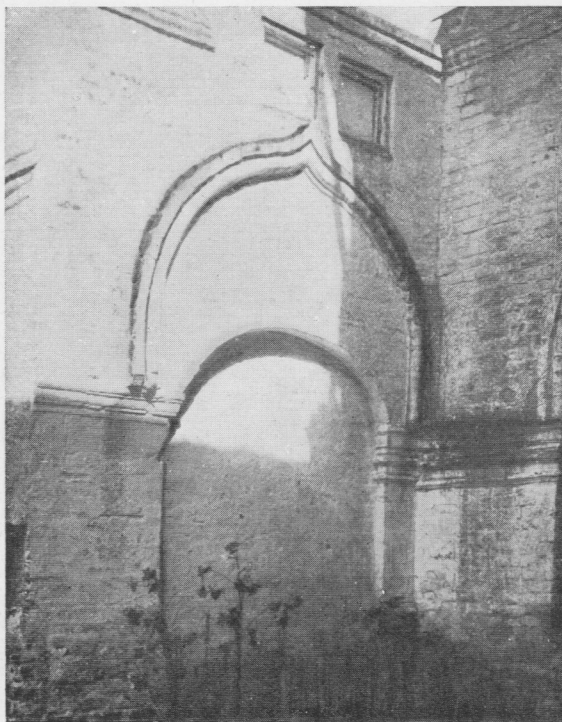
Деталь южной стены северного крыльца
