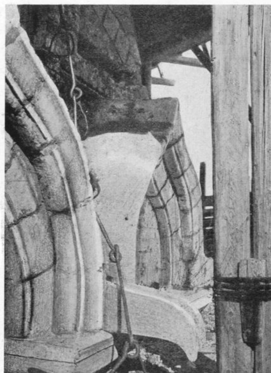
Детали кокошников и водометов южной стены восьмика. Между кокошниками видна цепь железной стремянной лестницы
