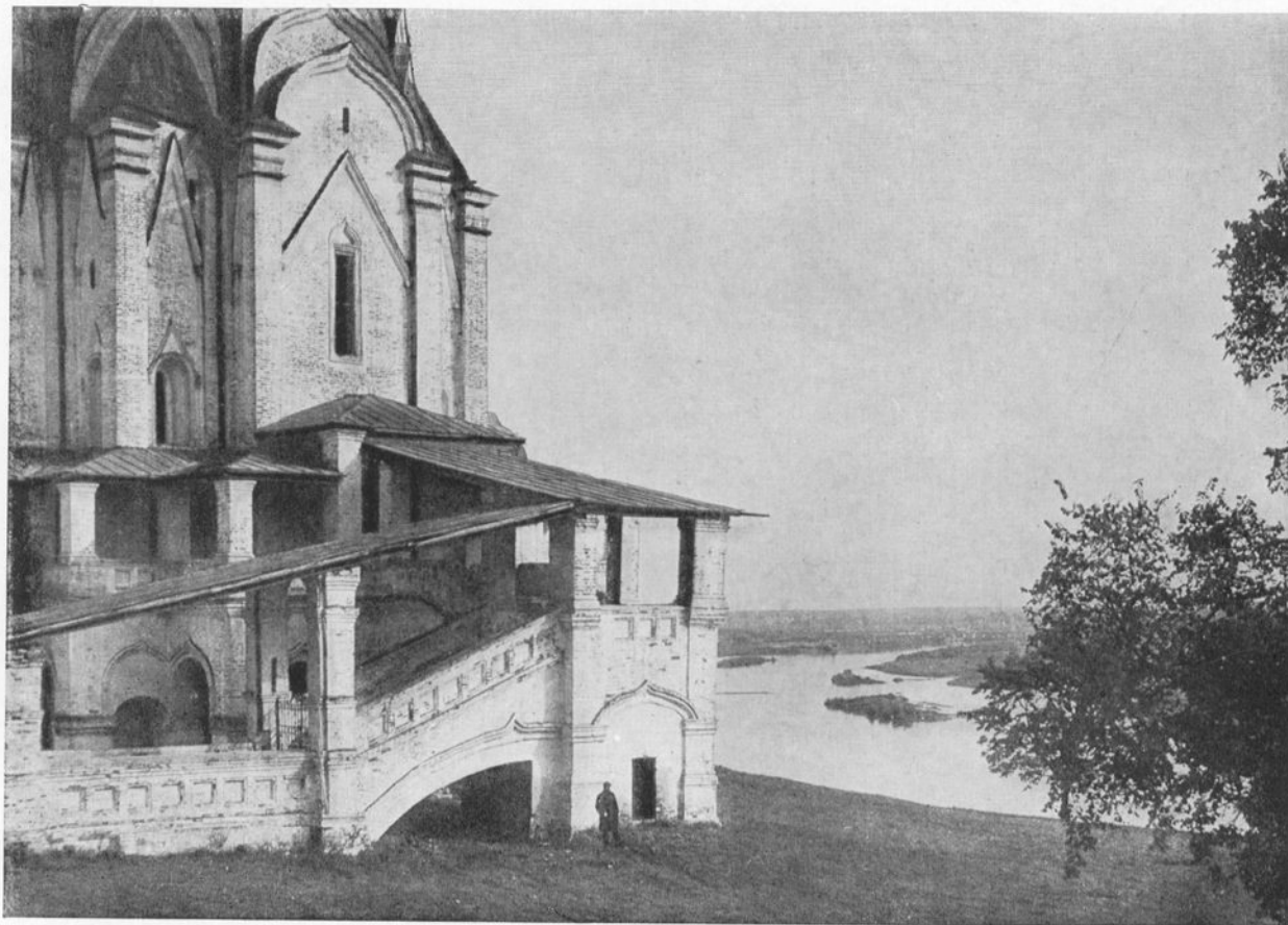
Фрагмент южного фасада
