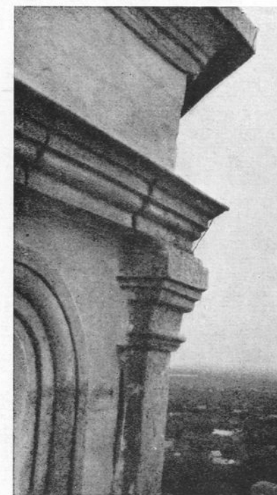
Деталь угла восьмигранного барабанчика купола. Слева видно обрамление ложного окна
