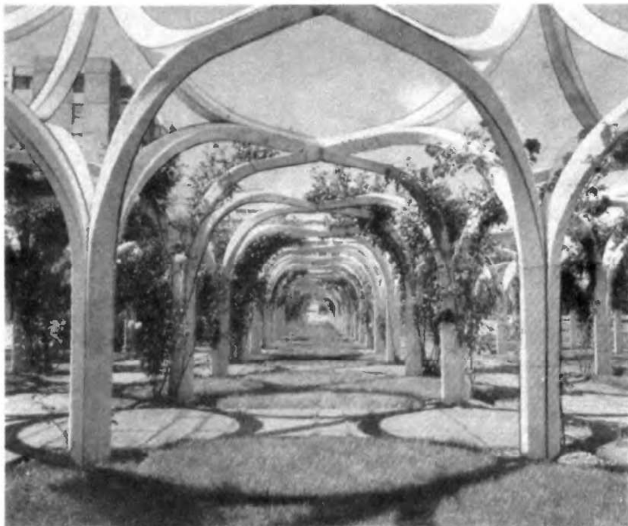
Пергола сооружена из искусственного материала, дающего возможность изготовления серии отдельных элементов, соединяемых на месте. Материал позволяет создавать непривычные архитектурные формы сооружения
