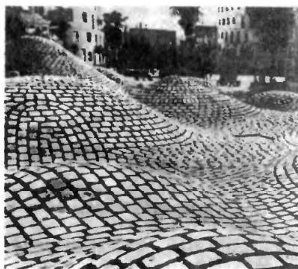
Покрытие поверхности искусственного игрового микрорельефа мощением из брусчатки
