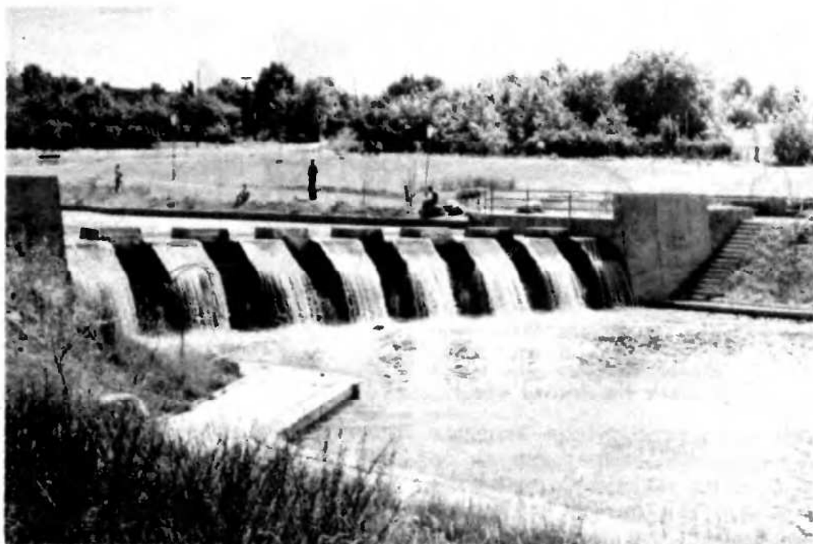
Минск. Слепянская водная система. Водопад в парке жилого района "Уральская-Менделеева". Архитекторы Н. Жлобо, Л. Жлобо
